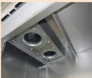
Un plafond de la salle à utilisation ouvert avec vue sur les turbines d'air circulation
